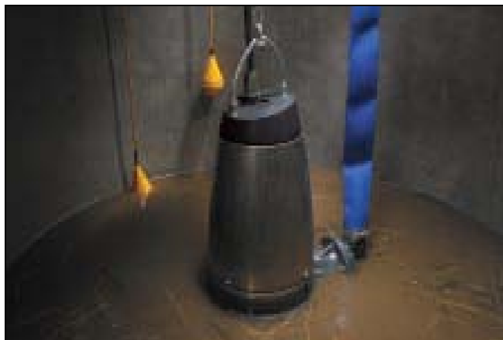
2. Befintlig sedimenterings-, mät- & pumpbrunn
