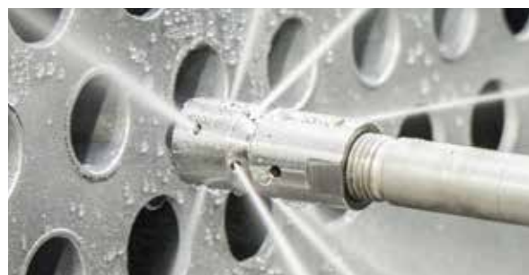
Rengöring av värmeväxlare
